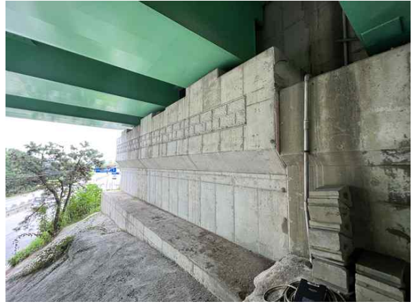
교대 A1 상태양호
