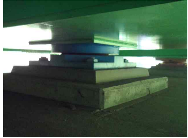
교량받침 P1-Sh2 상태양호
