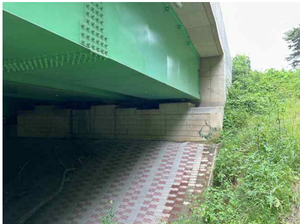
교대 A2 상태양호
