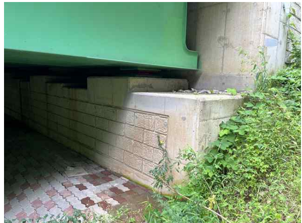
교대 A2 상태양호
