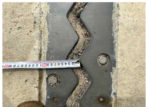
신축이음 이동량 측정
