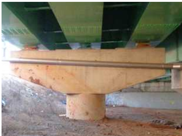
교각 P1 코핑부 상태양호
