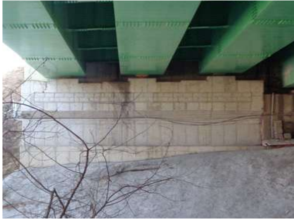
교대 A1 상태양호
